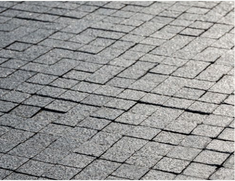
Dojścia i dojazdy – kostka granitowa cięta
